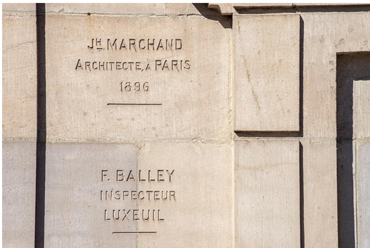
Façade sur la rue de Grammont, partie centrale, inscription : "JH MARCHAND / ARCHITECTE A PARIS / 1896 / F. BALLEY / INSPECTEUR / LUXEUIL".
