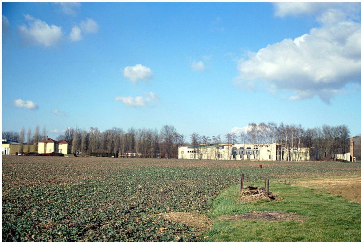
Local du comité d'entreprise : vue d'ensemble depuis l'est.
