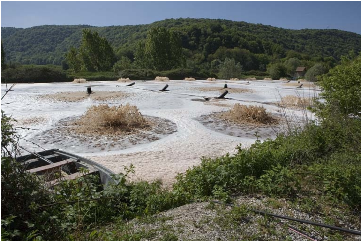
Bassin de décantation, à l'est de la papeterie.
