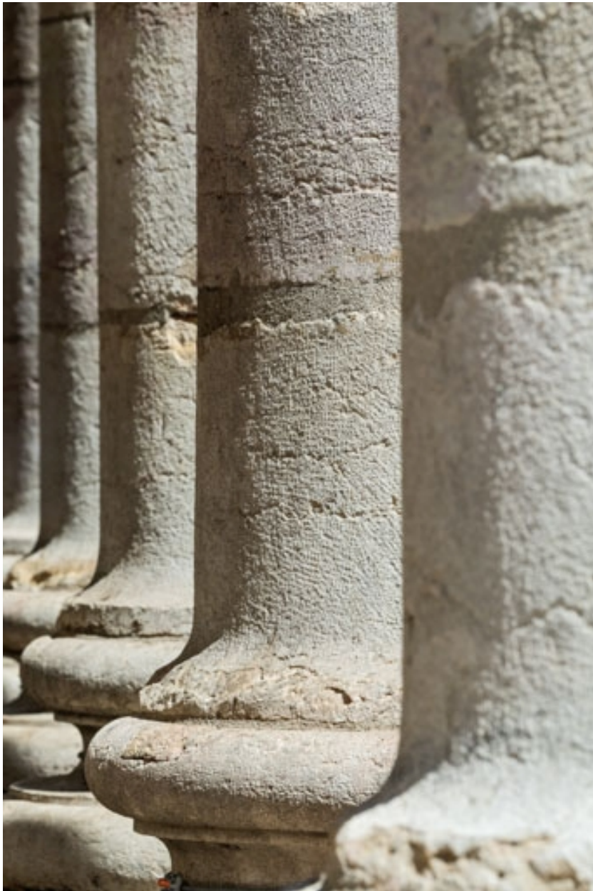
Façade antérieure : base des colonnes.
