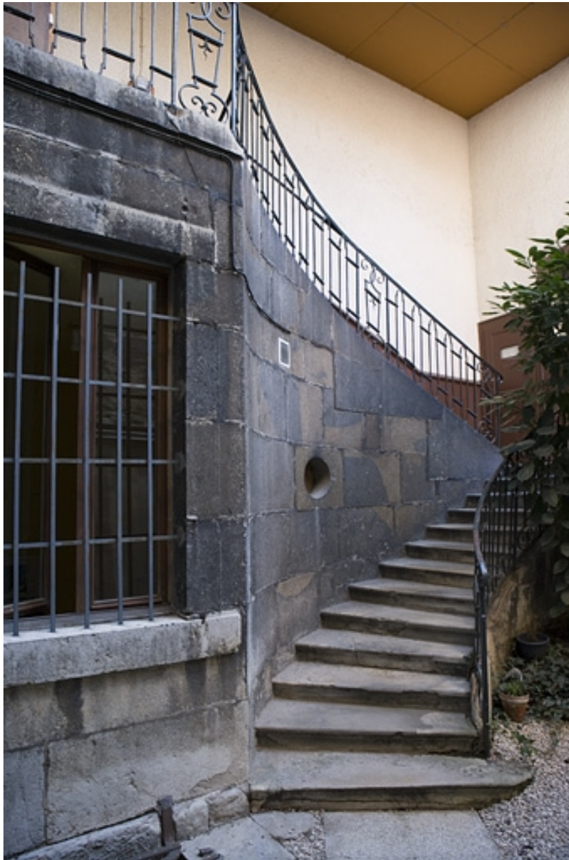
Vue du départ de l'escalier à cage ouverte.
