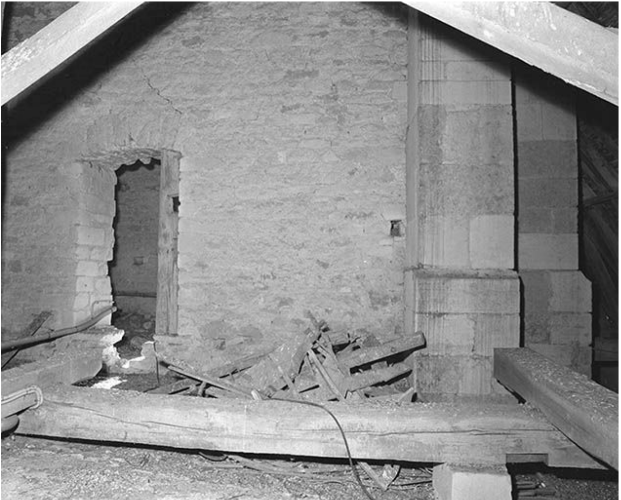
Comble de la nef : mur du clocher.
