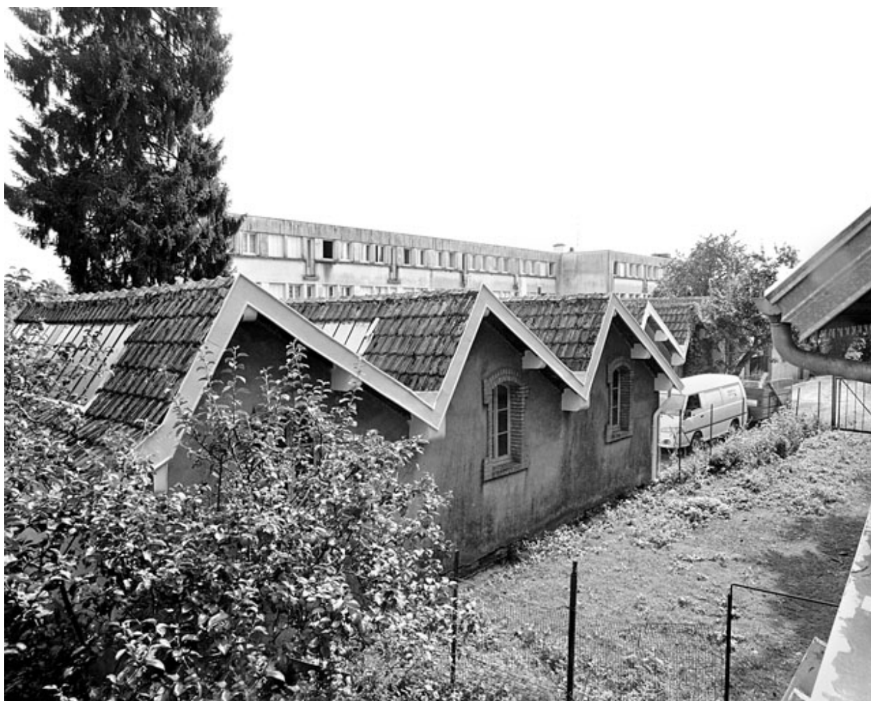
L'atelier de fabrication depuis le nord.
