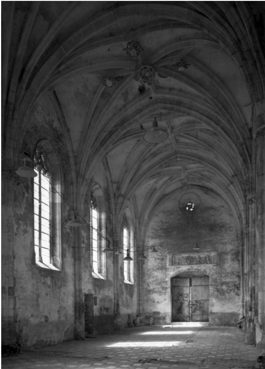
Chapelle de l'ancien château : nef, vue prise du choeur.
