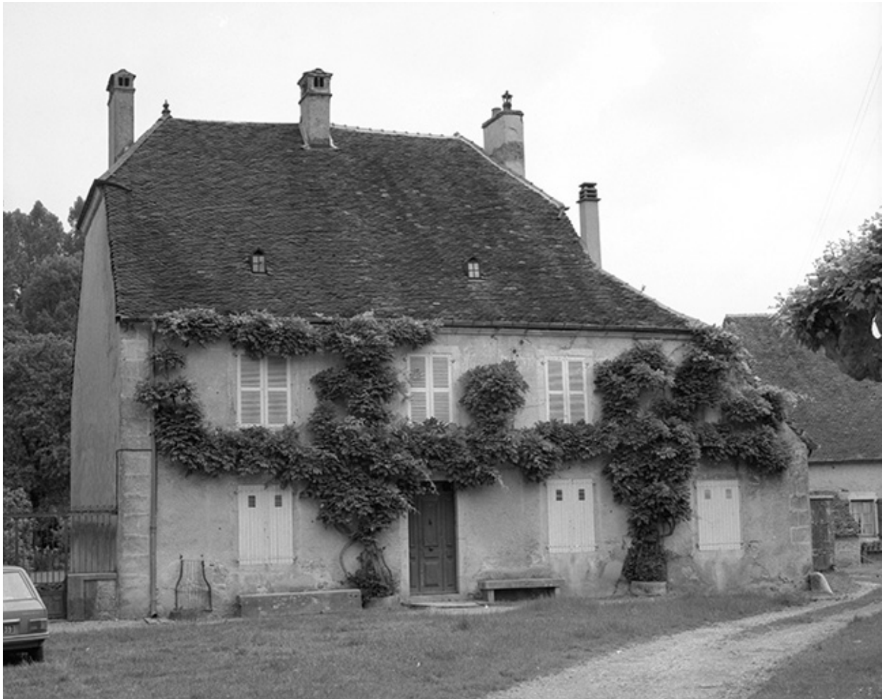
Maison : façade antérieure.
