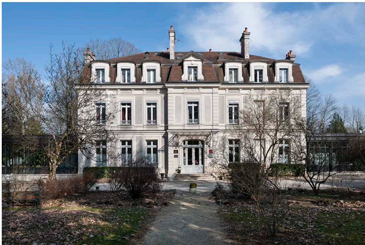
Logement patronal. Façade ouest.
