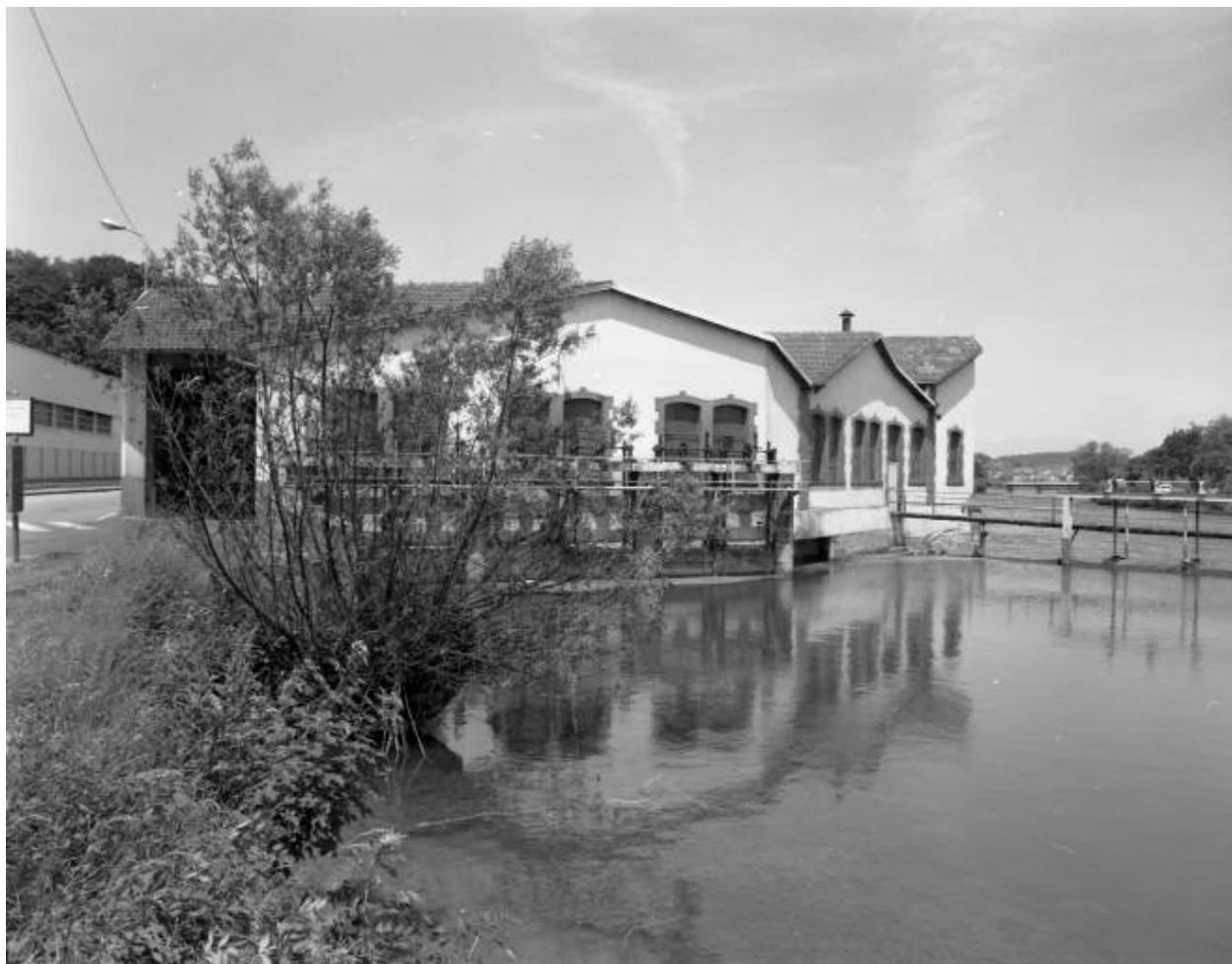
Ancienne fonderie vue du sud.
