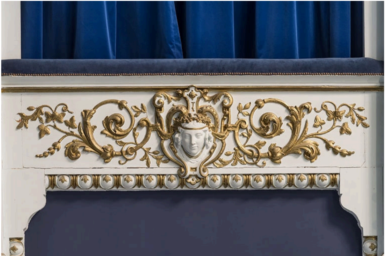
Décor du garde-corps de la loge d'avant-scène côté cour, au 2e balcon.
