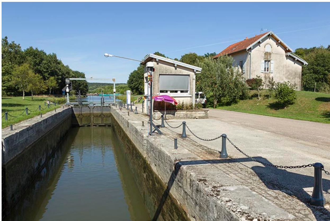
L'écluse à sas.
