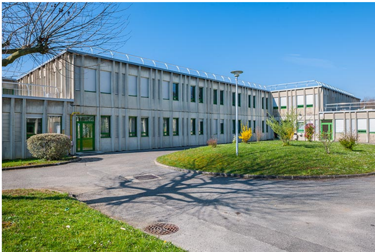
Infirmierie : façades postérieures
