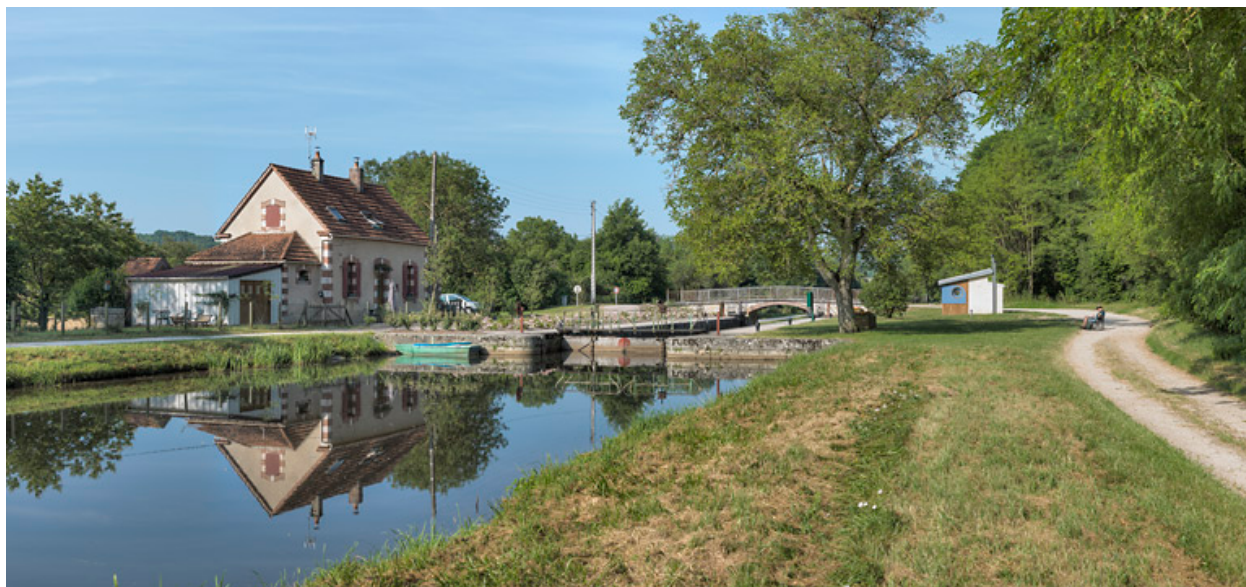
Vue d'amont du site d'écluse.
