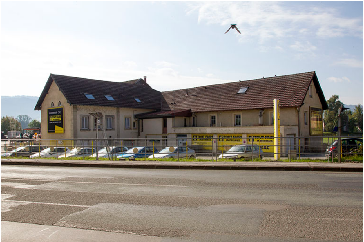
Façades antérieure et latérale droite.
