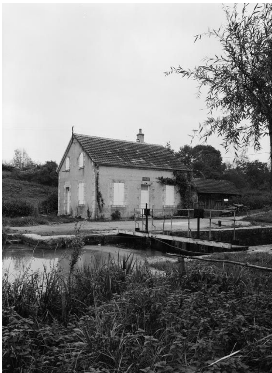
La maison éclusière vue d'amont.
