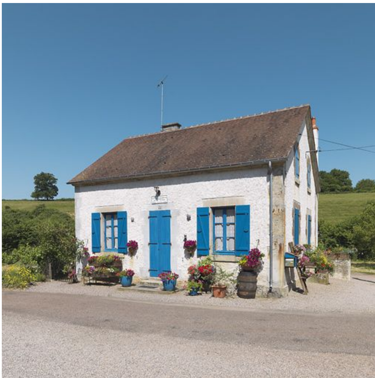
Vue de la maison éclusière de 3/4.
