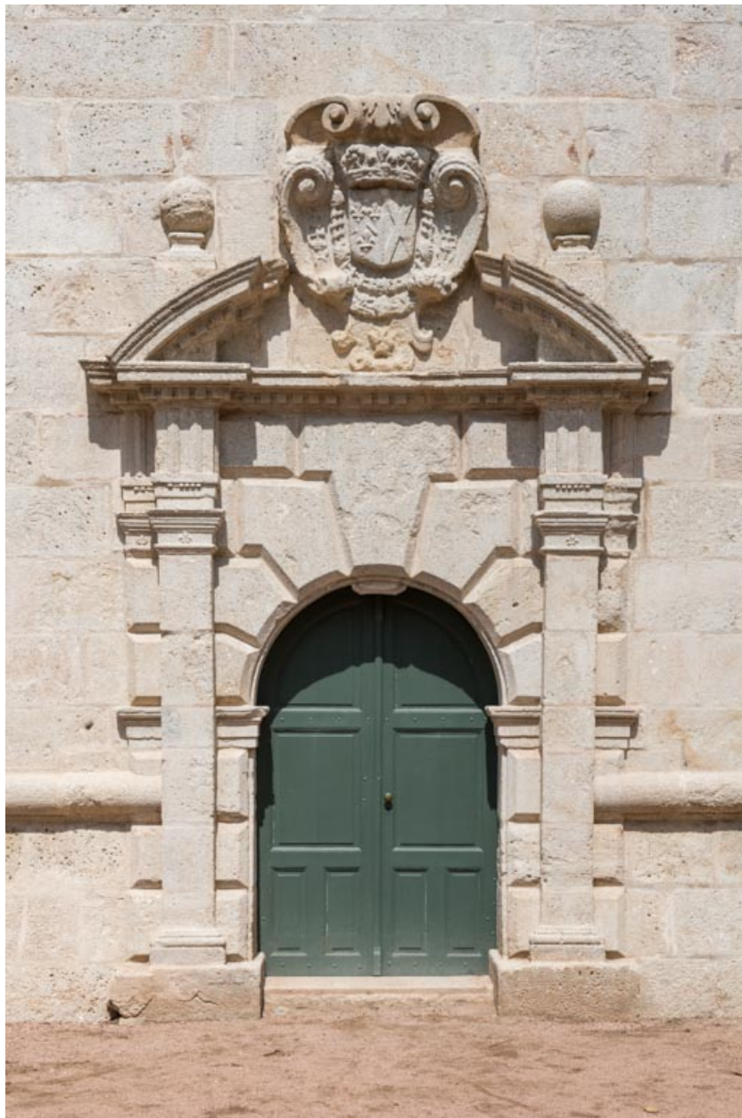
Façade sud-est, partie droite, mur d'échiffre du grand-degré, portail.
