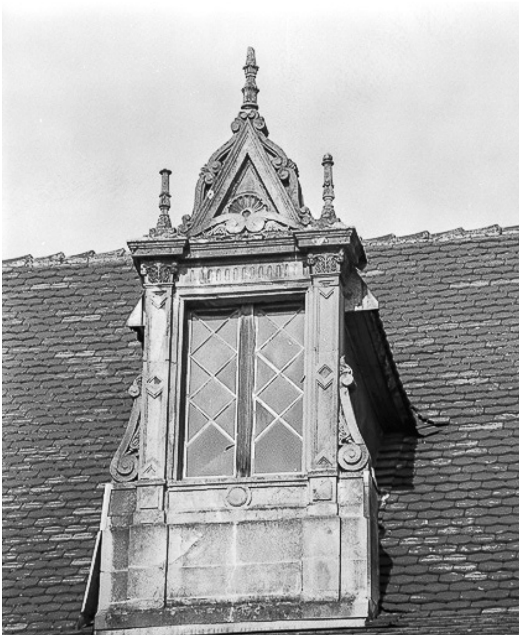
Façade sur rue, détail : lucarne.
