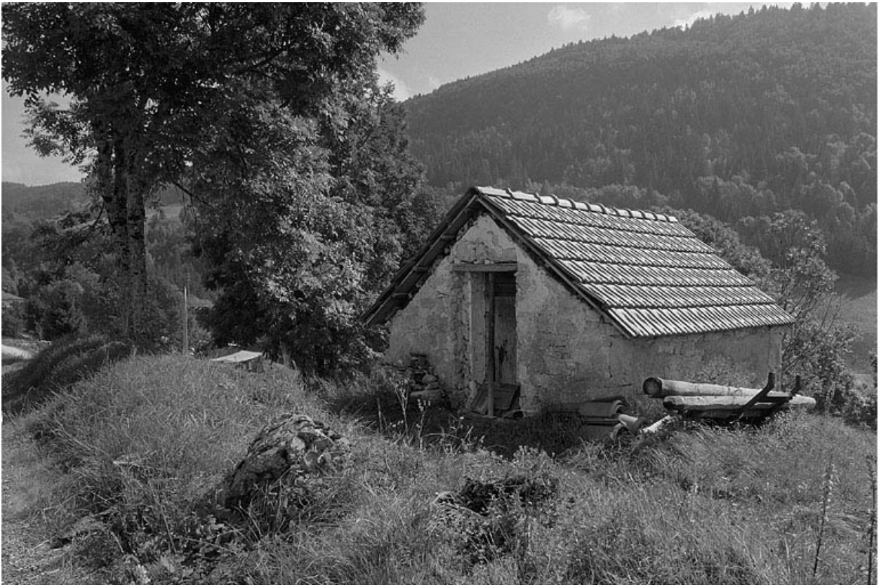
Grenier fort en pierres à Montépile, hameau de Septmoncel.
