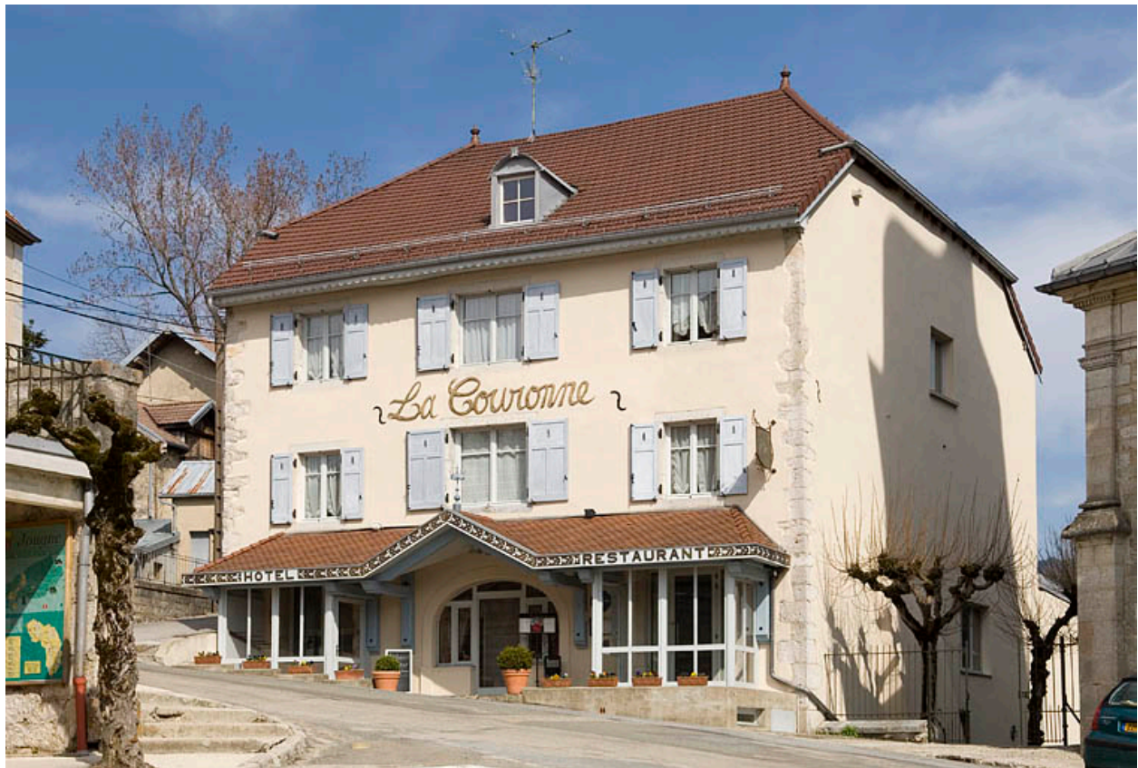
Façade antérieure et façade latérale droite.
