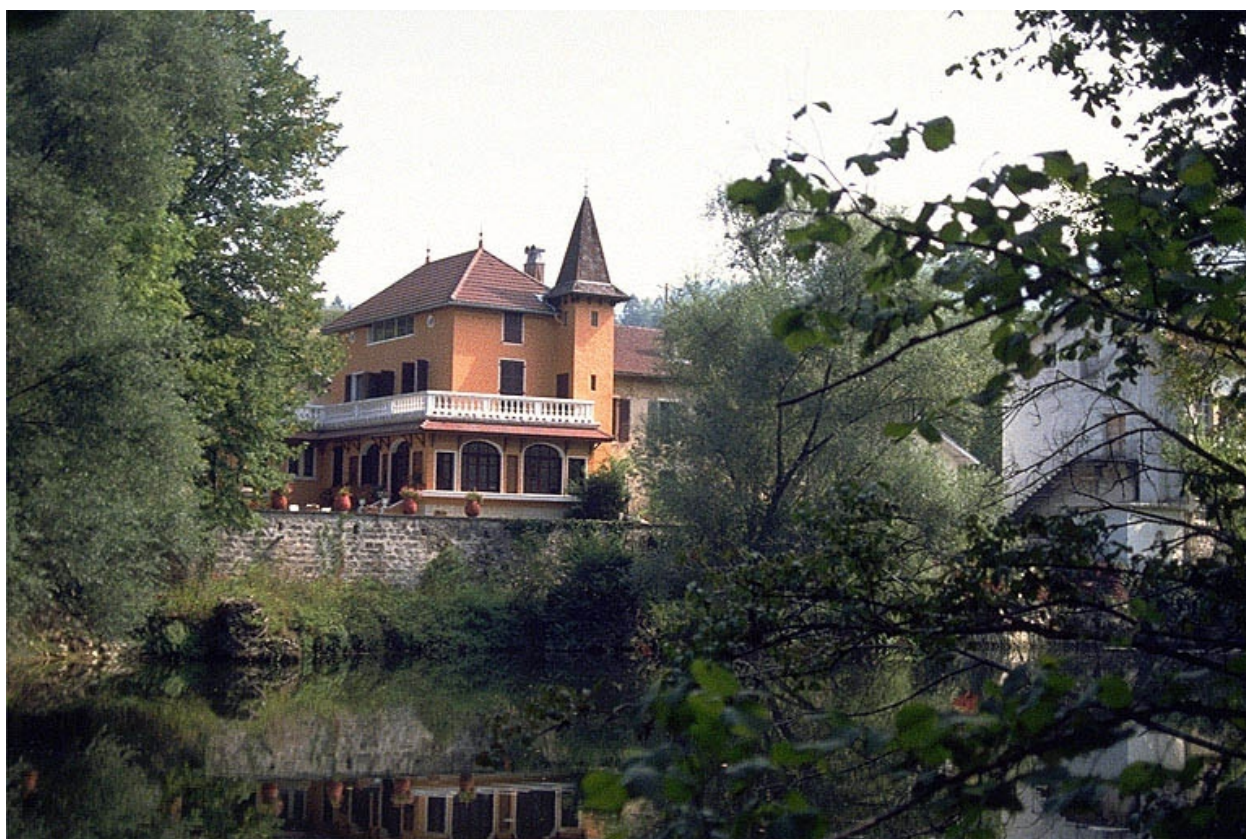
Logement patronal, depuis l'ouest.
