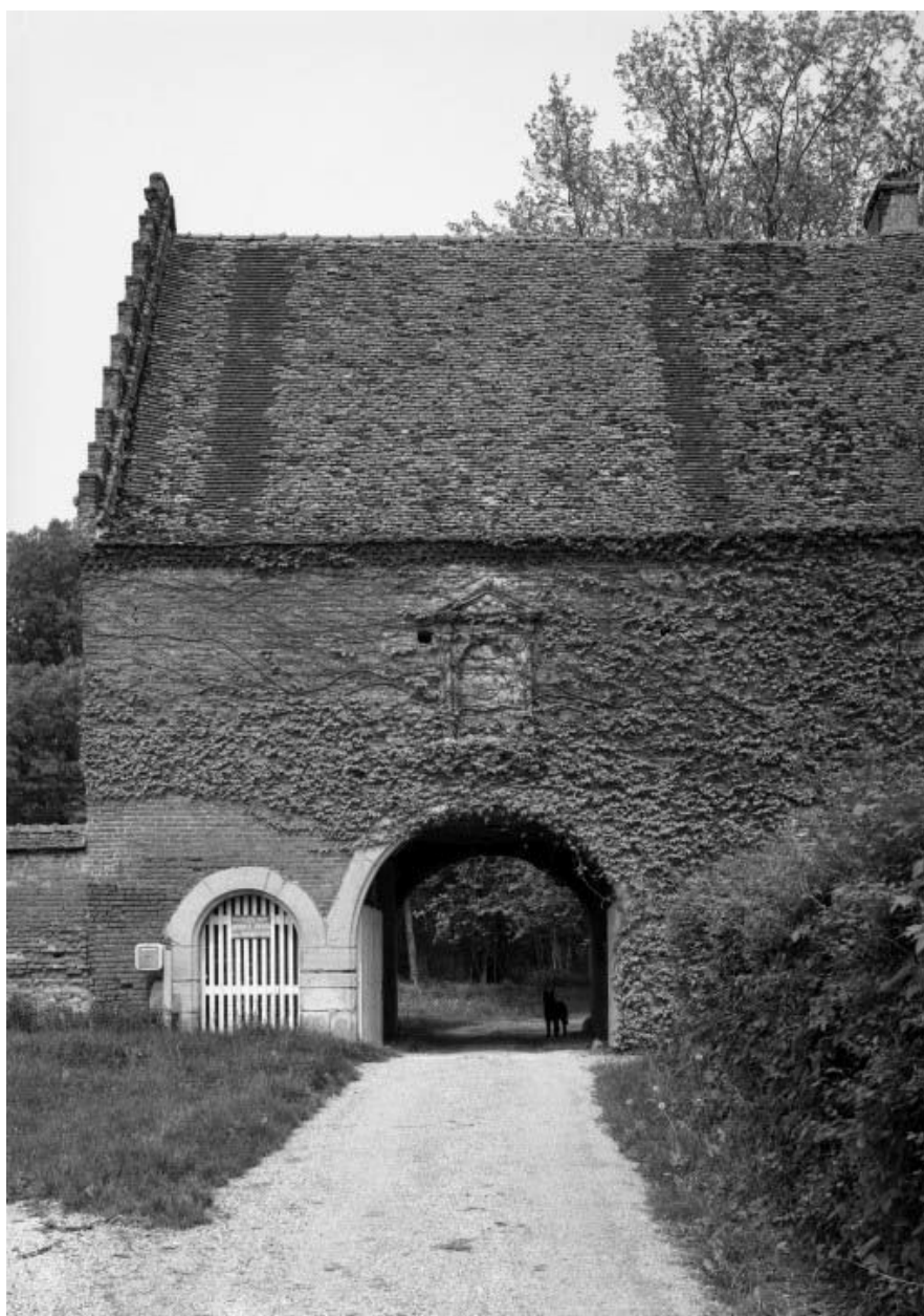
Bâtiment de l'ancien château : corps de passage.
