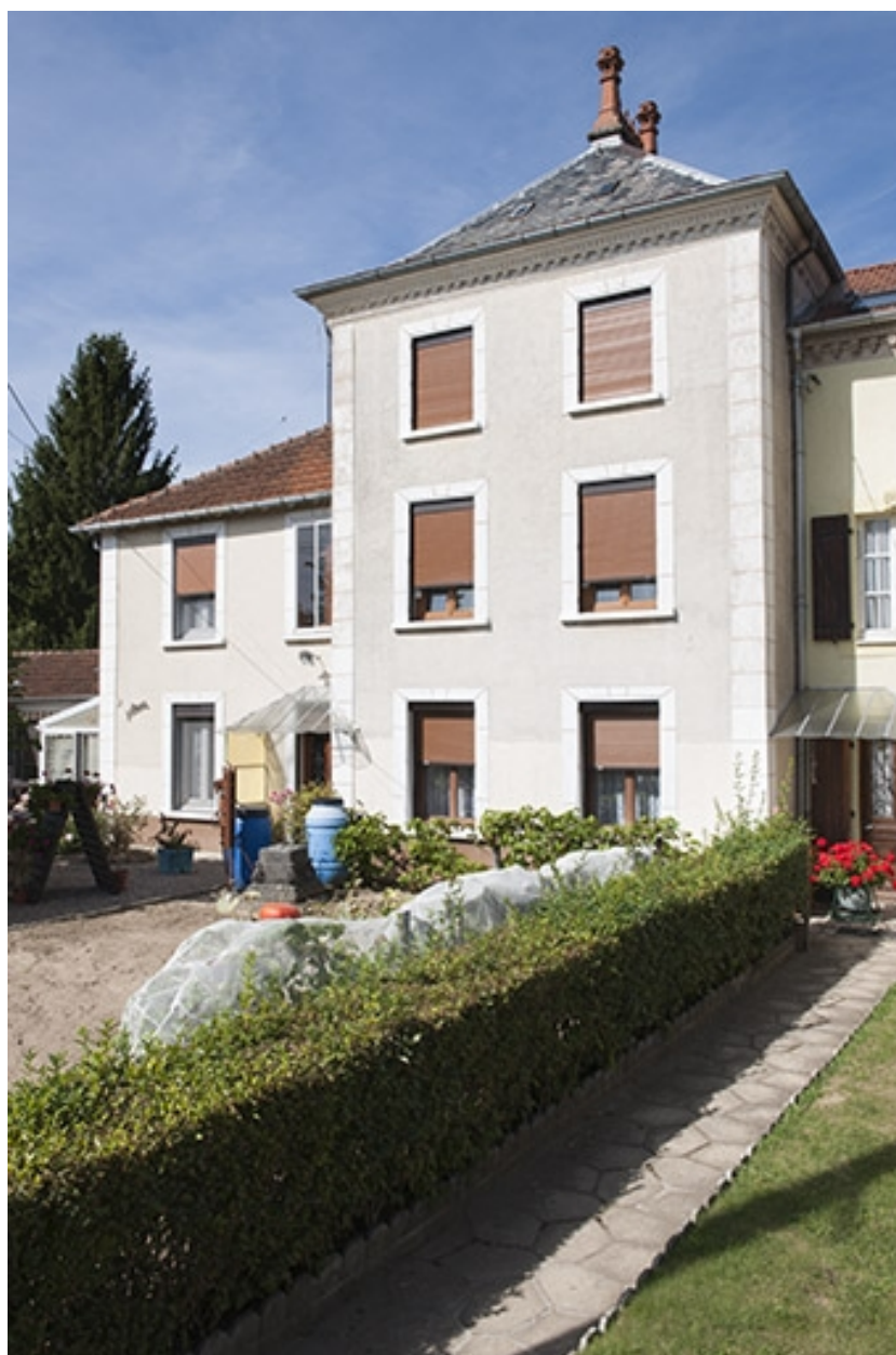
Façade antérieure, partie ouest.
