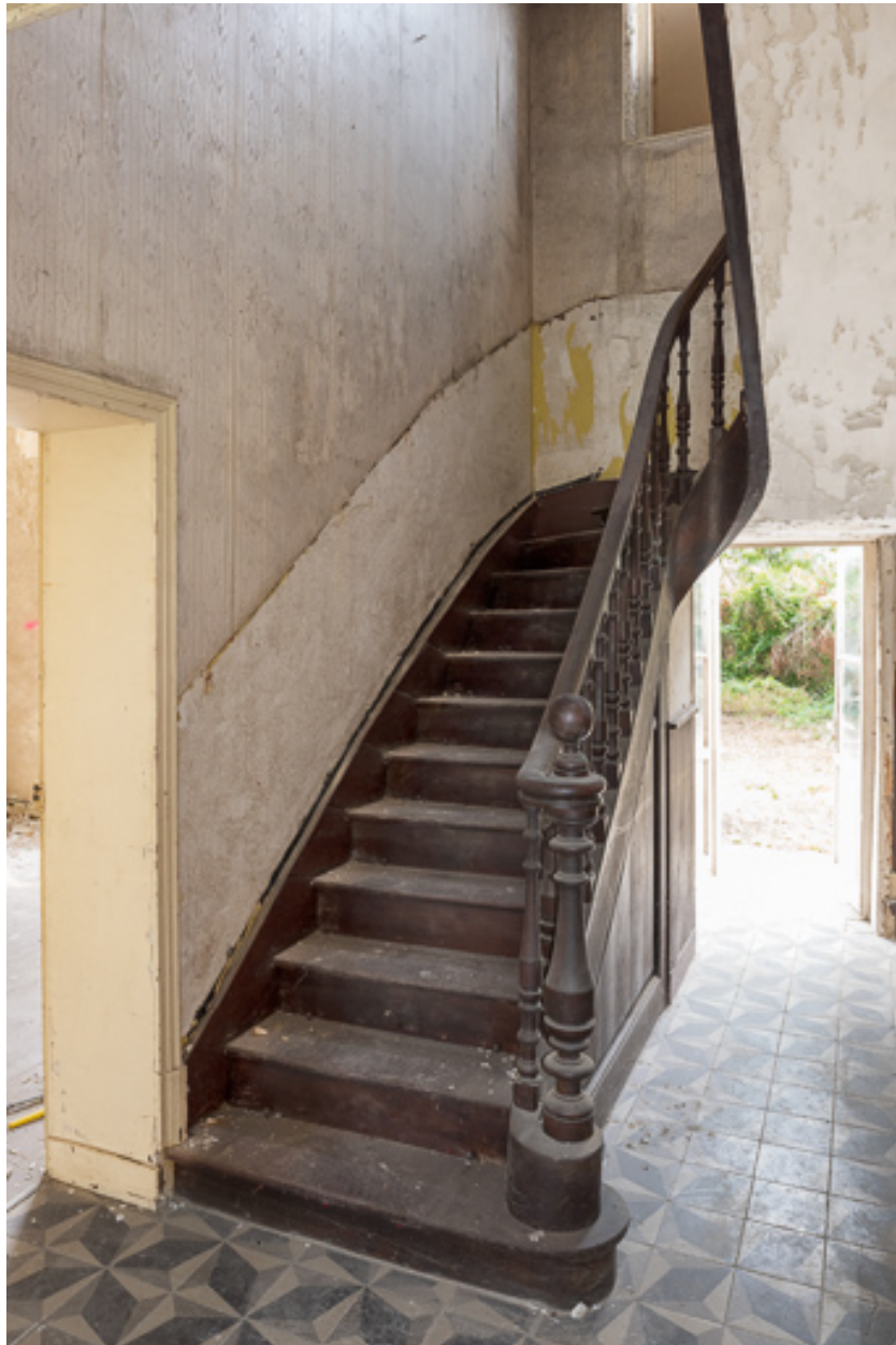
Escalier du corps principal, rez-de-chaussée.
