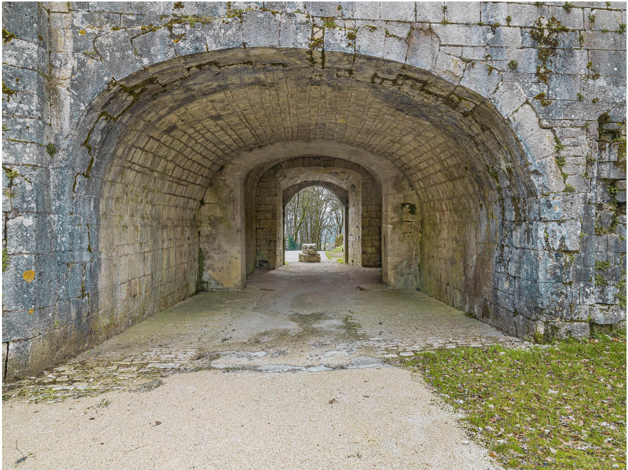
Le passage, vue depuis la cour intérieure.
