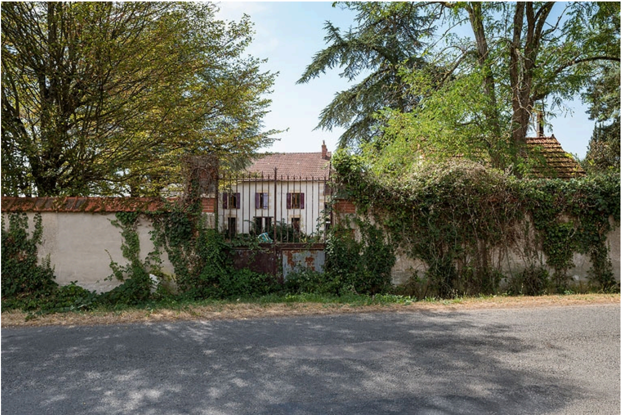
Portail d'entrée sur la rue des Fonts-Bouillants.
