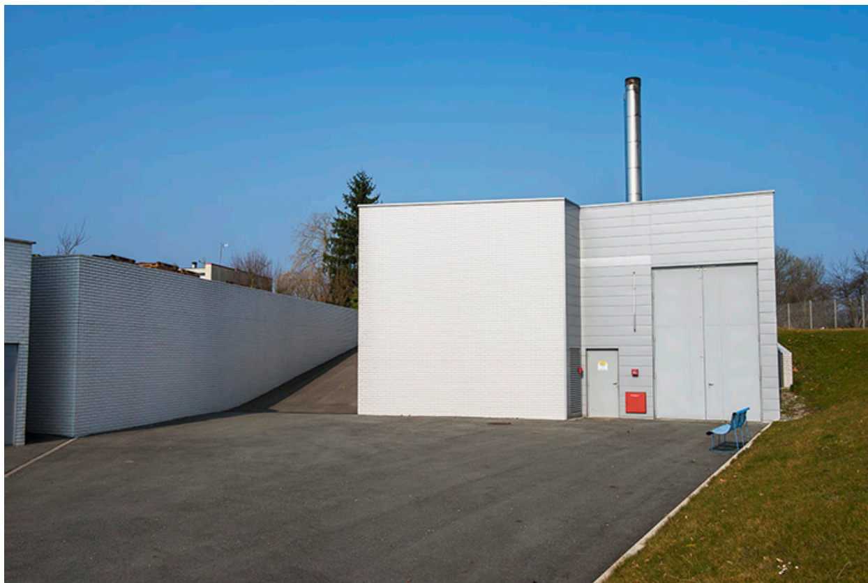
Façade postérieure sud de la chaufferie.
