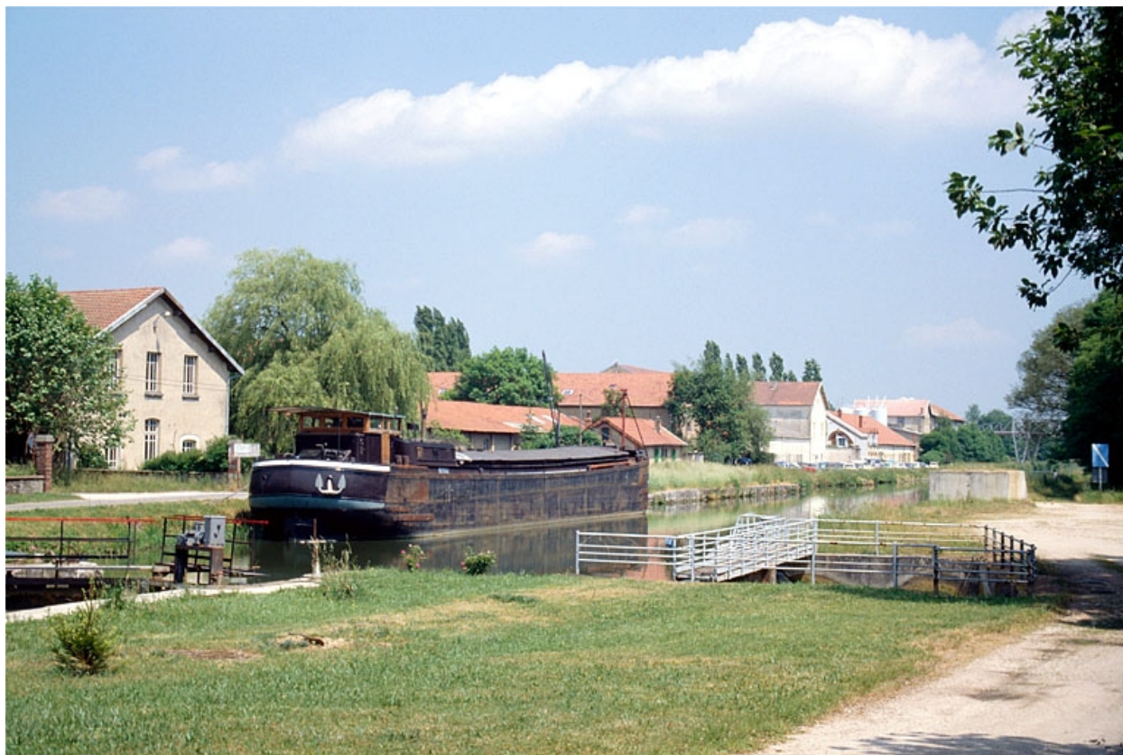
Vue d'ensemble de l'usine, depuis l'écluse.
