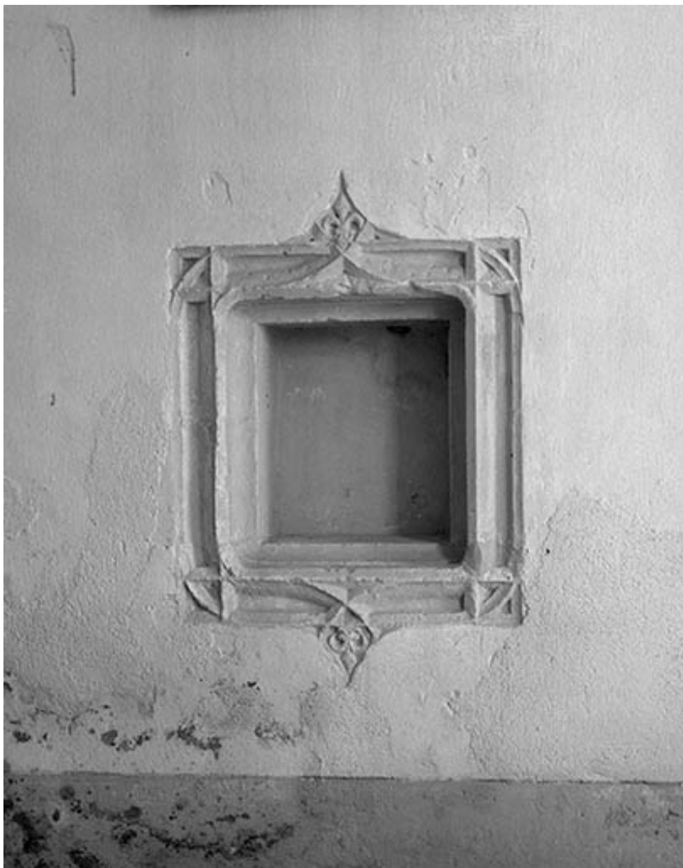
Extérieur : détail, niche.
