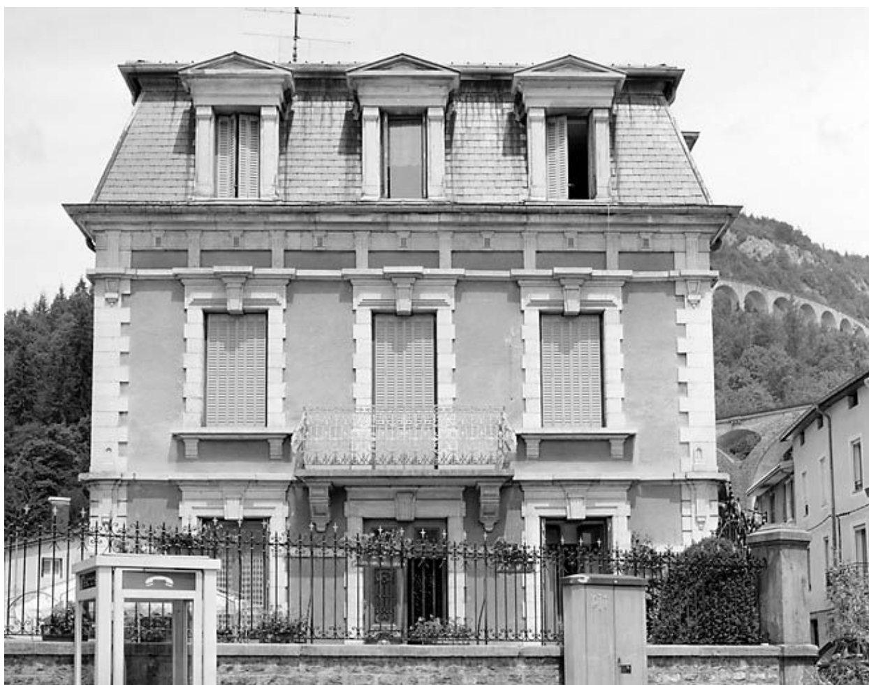
Elévation latérale gauche (vue rapprochée).
