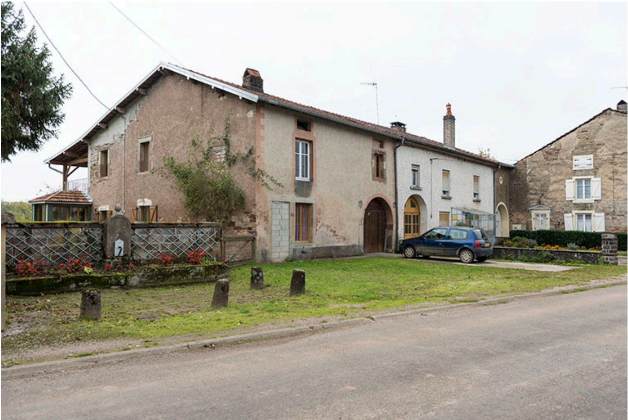
Alignement de fermes, Grande rue.
