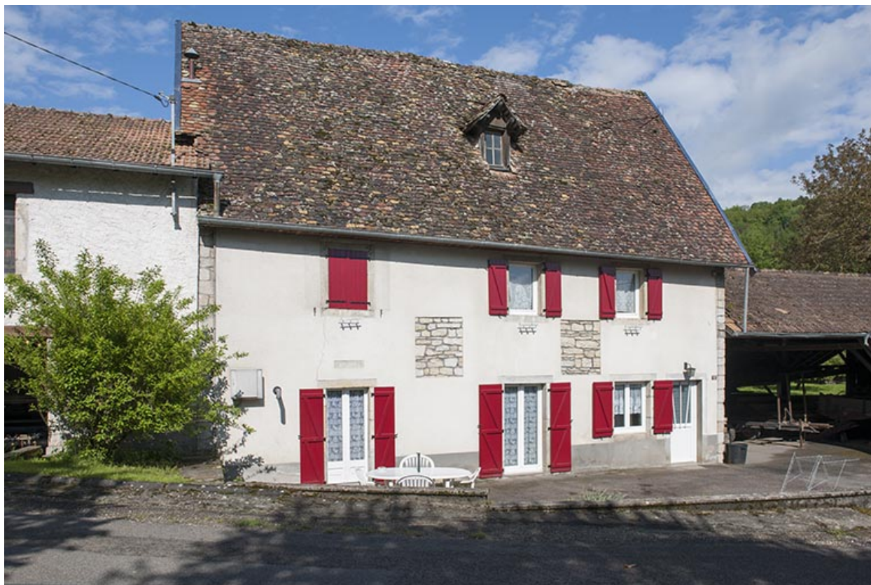
Façade est du moulin.
