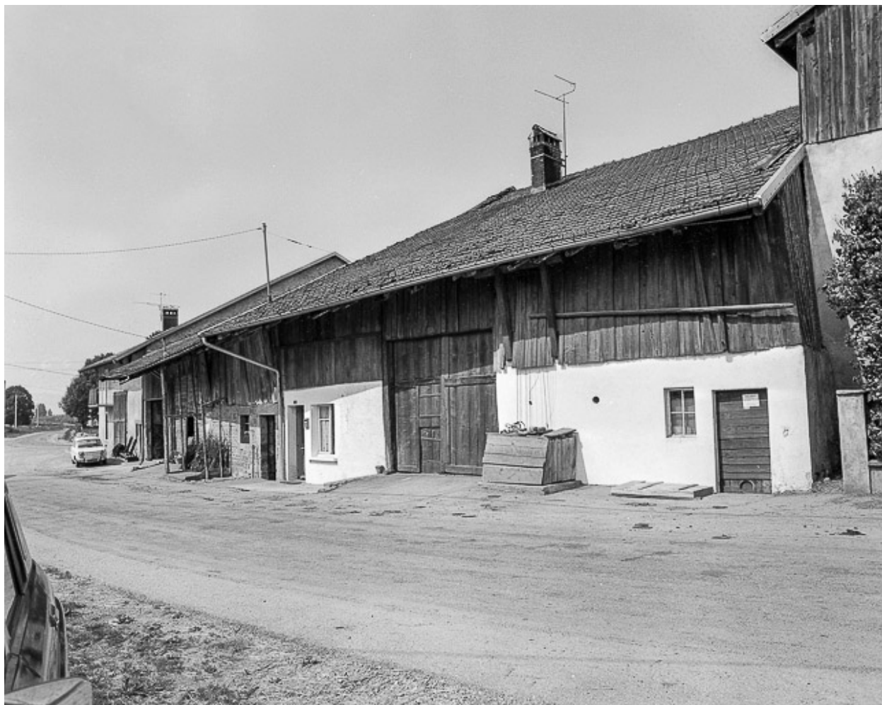
Ferme située rue de l'Ecole : façade antérieure.
