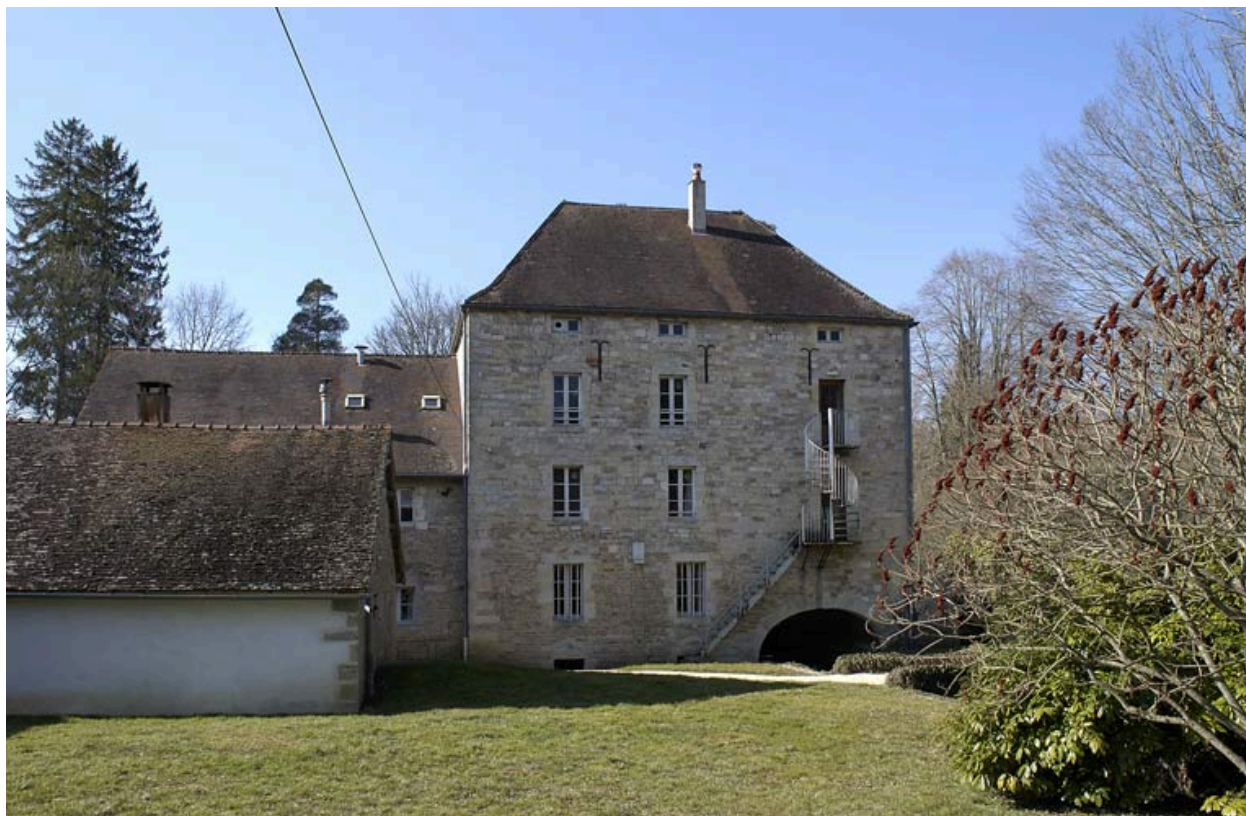
Ancien moulin à eau : élévation est.
