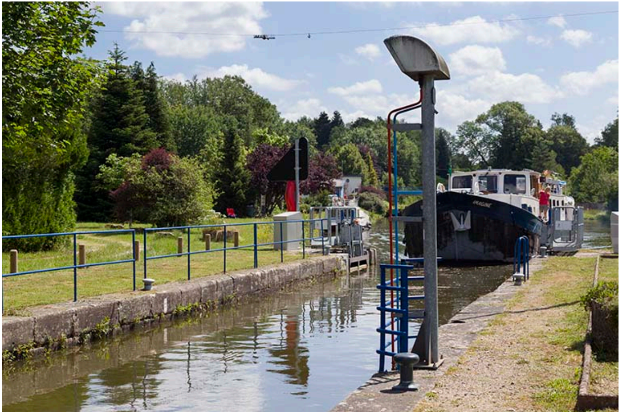
L'écluse de Pont-du-Bois.
