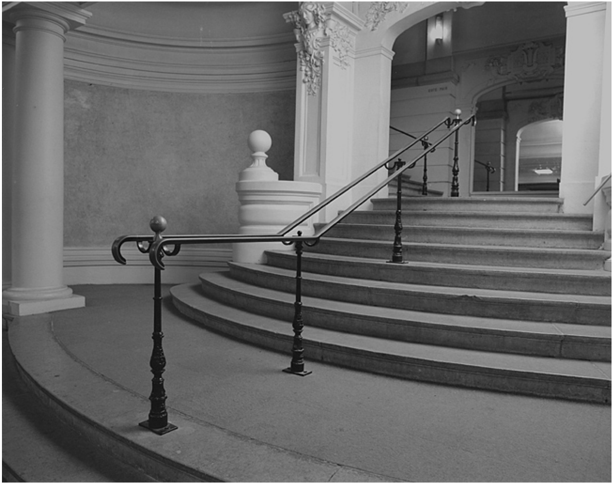
Grand escalier : détail.
