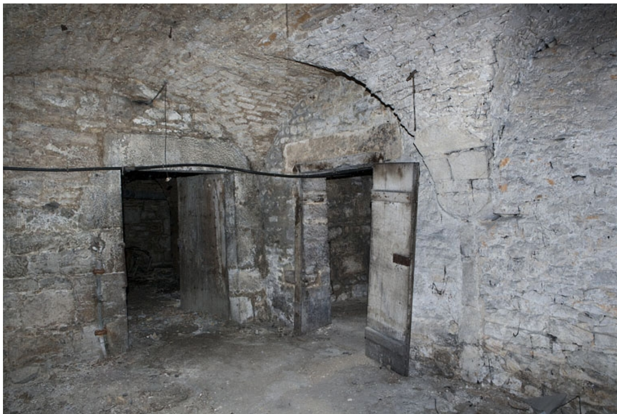
Logis principal, sous-sol : cave C.
