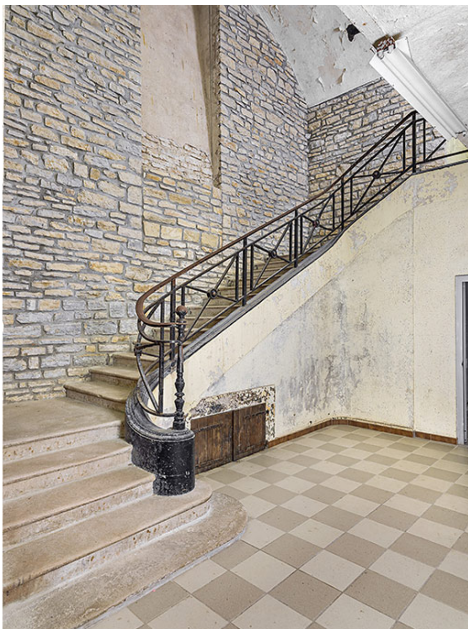
L'escalier vu depuis le rez-de-chaussée.
