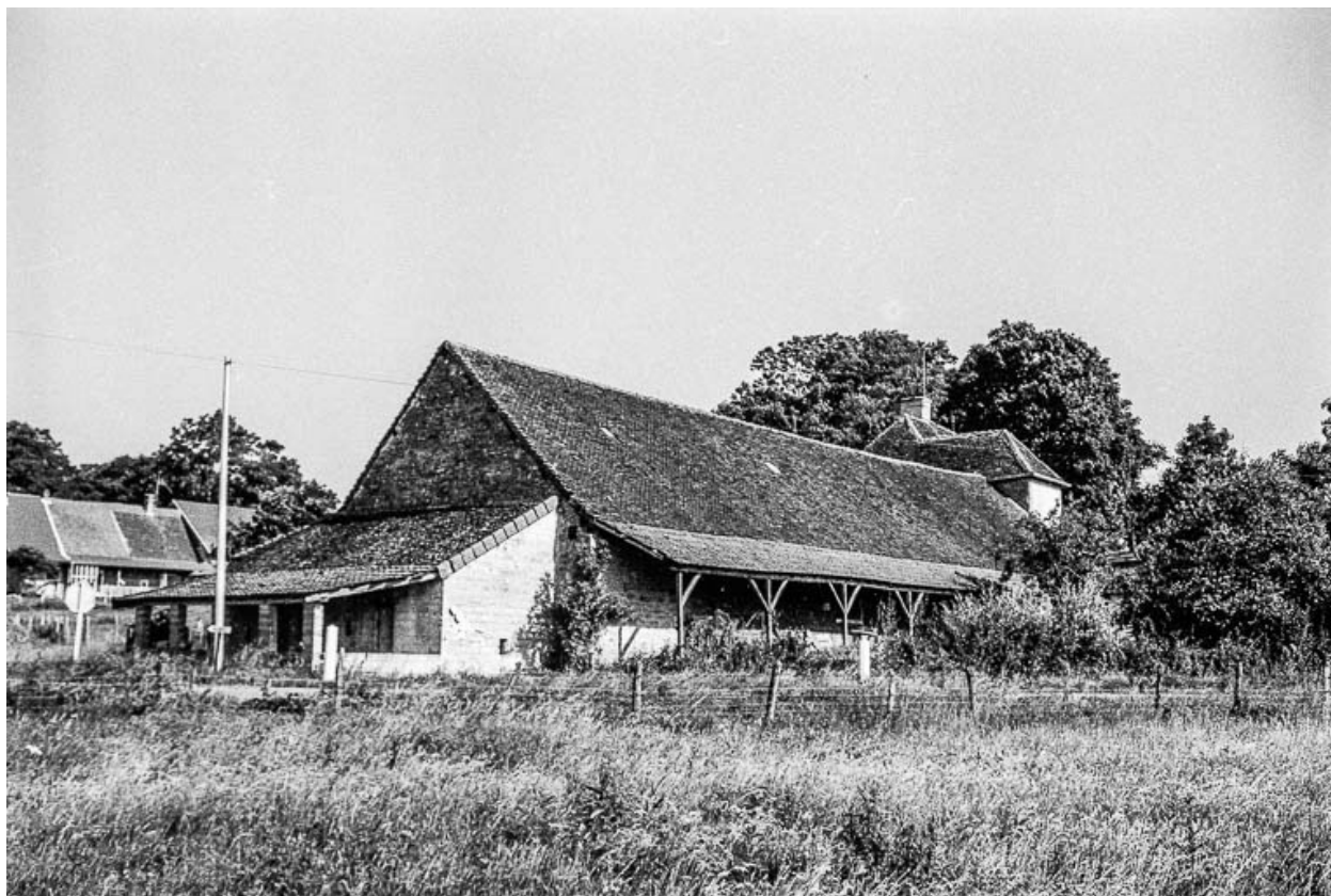
Ferme cadastrée 1811 D1 : façade postérieure de la partie agricole.
