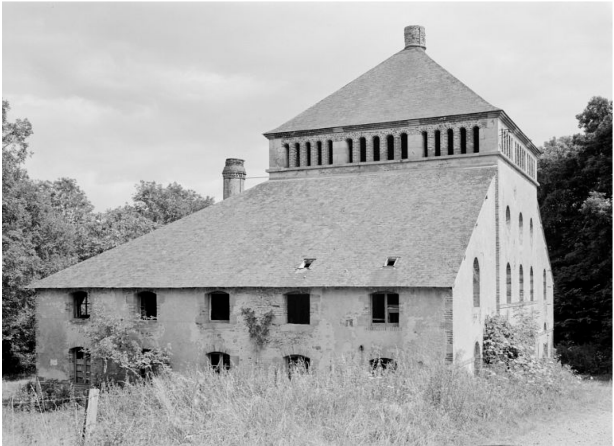
Vue depuis le nord-ouest, état en 1977.
