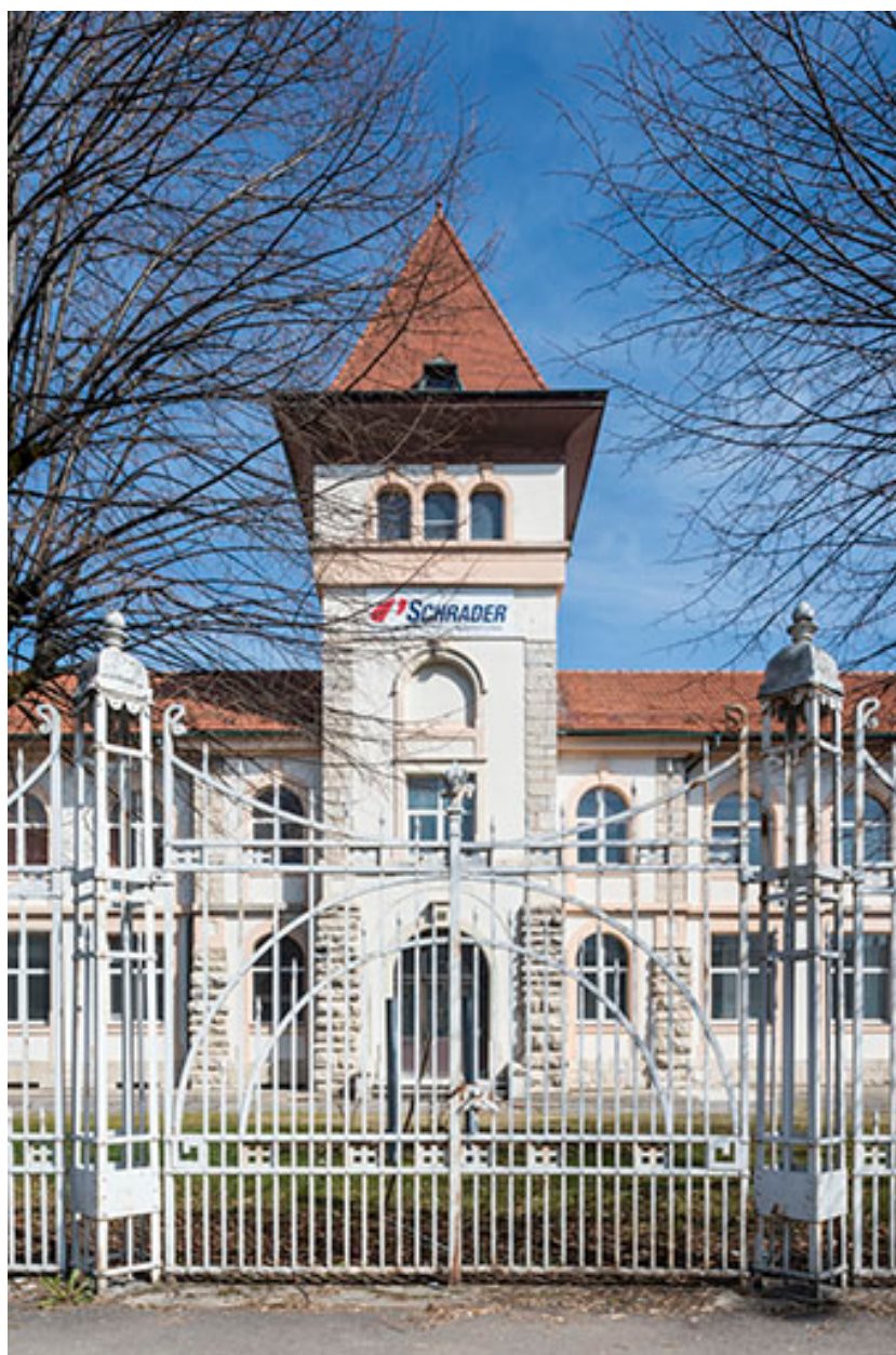
Avant-corps central du bâtiment administratif.
