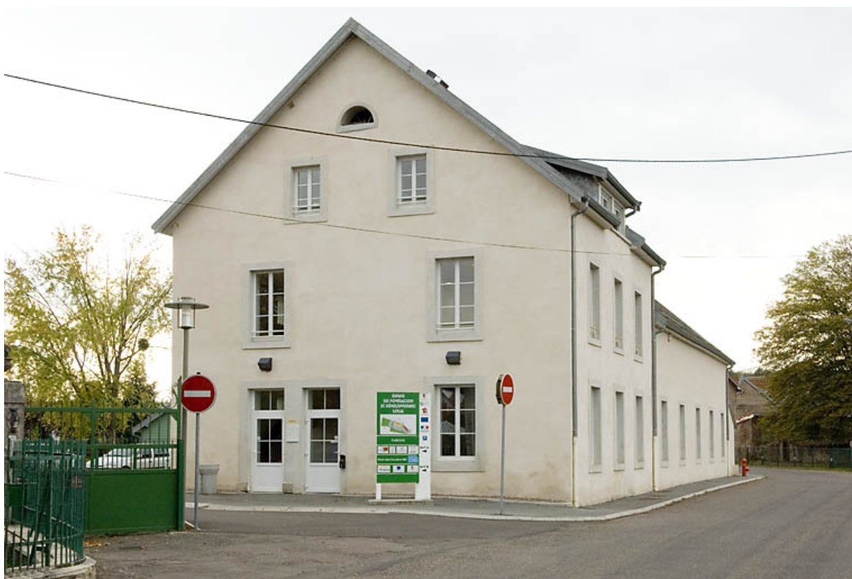
Logement et bureau (?). Vue de trois quarts.
