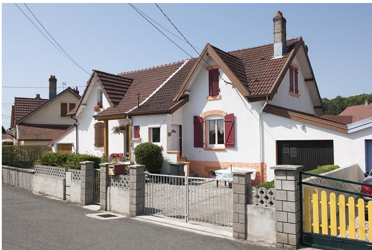
Maison jumelée rue des Lavandes.
