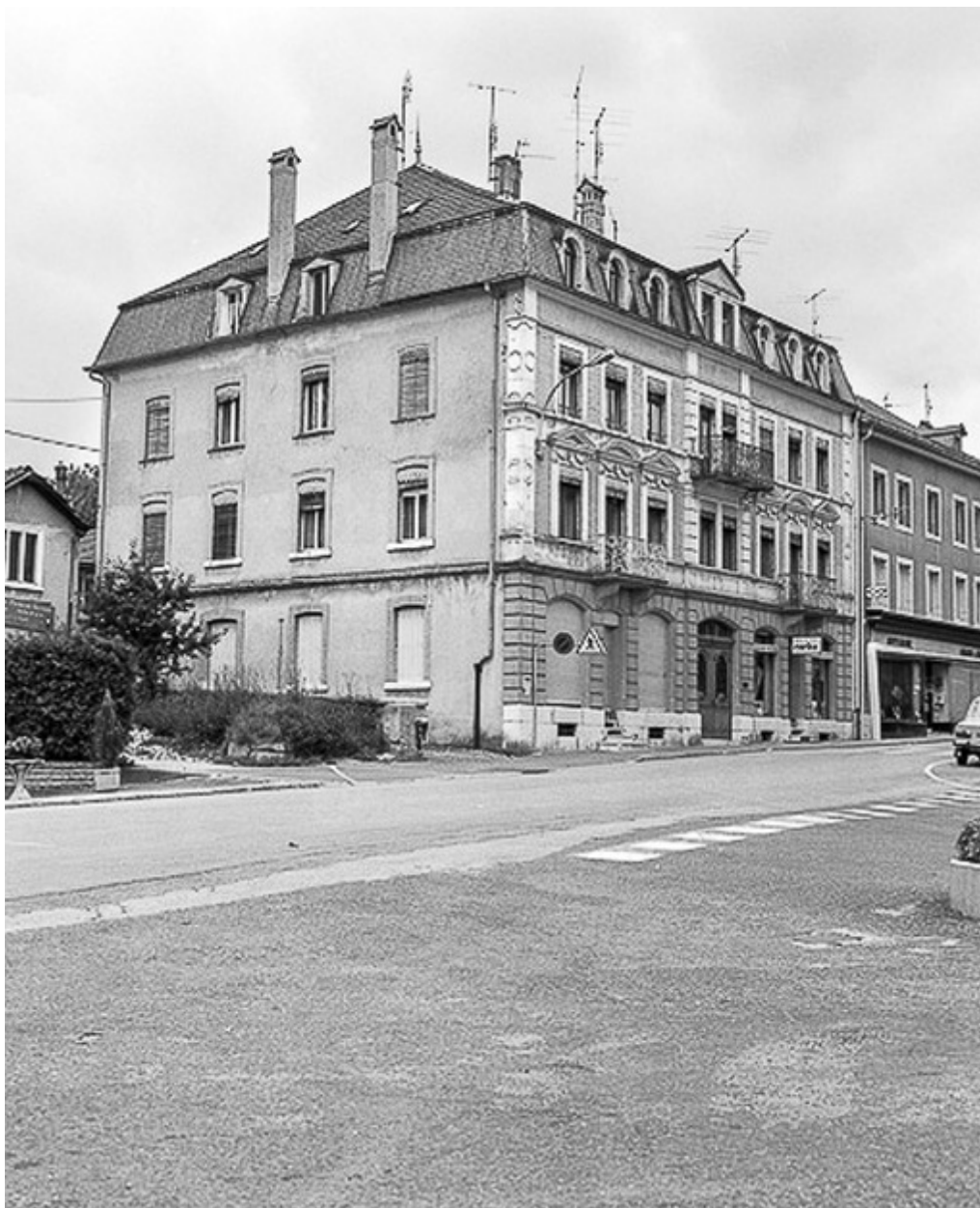
Façades antérieure et latérale gauche, en 1977.
