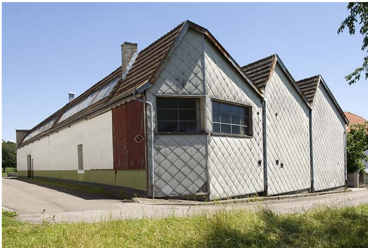
Bâtiments industriels. Vue depuis l'ouest.
