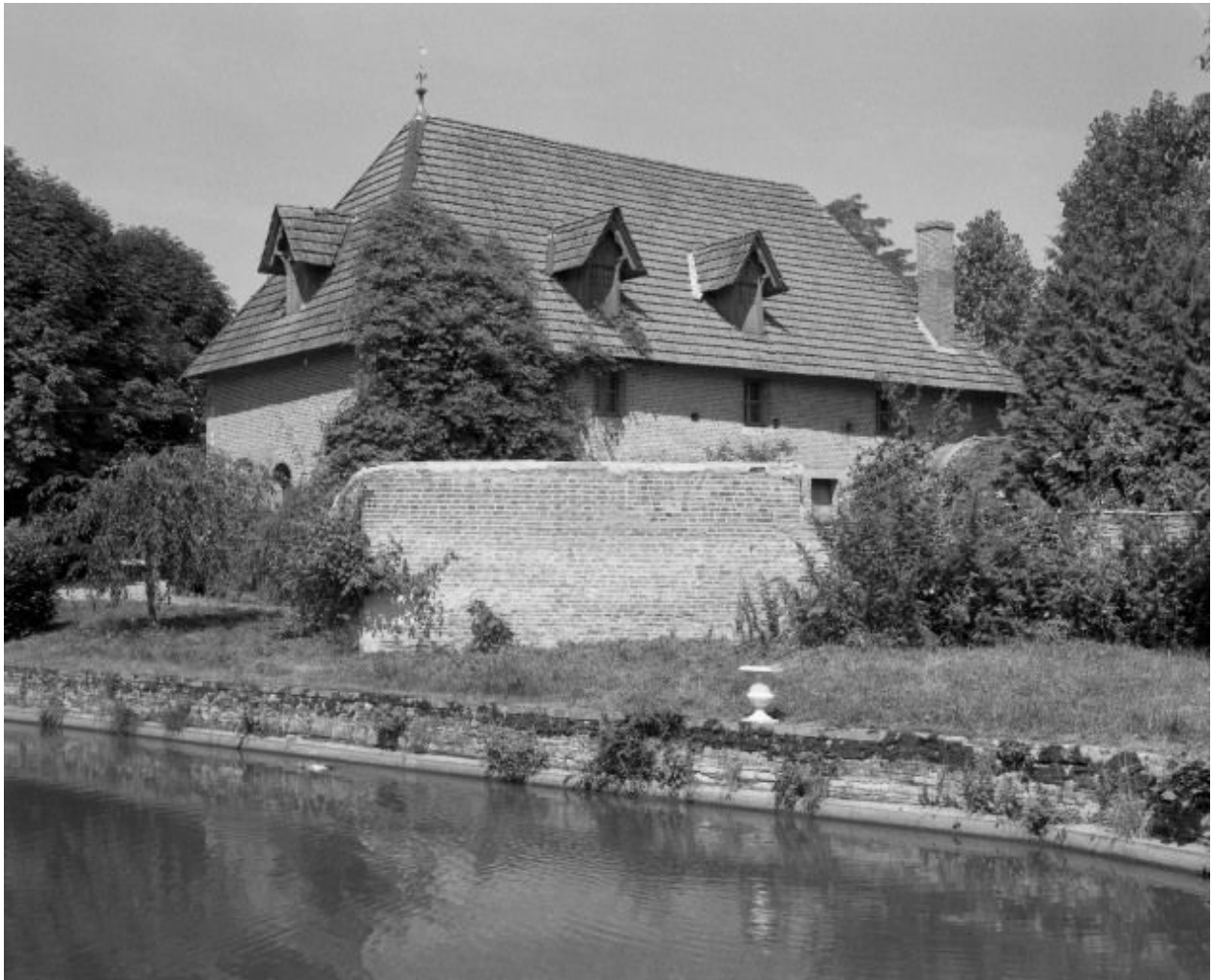
Communs et dépendances, façade postérieure du corps de bâtiment est.
