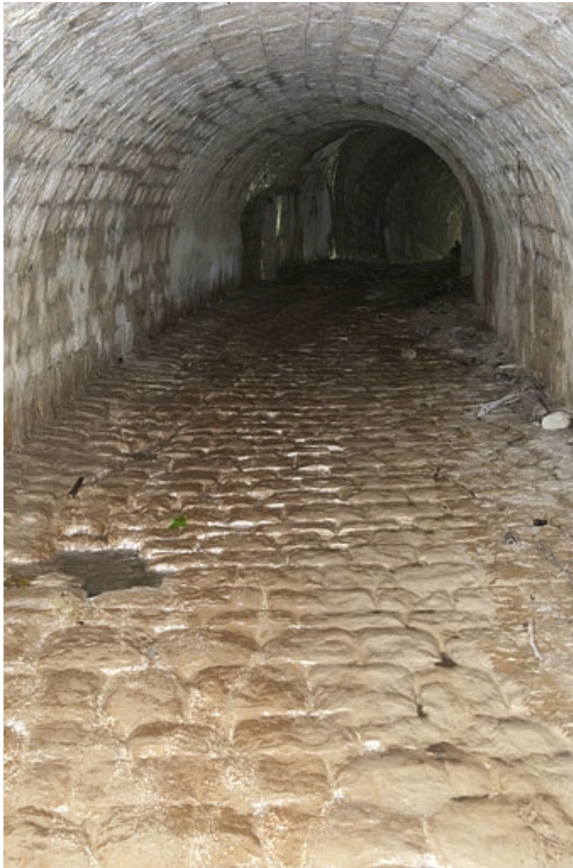
Intérieur du pont-aqueduc du Vaubillon (n° 6), détail du pavage.
