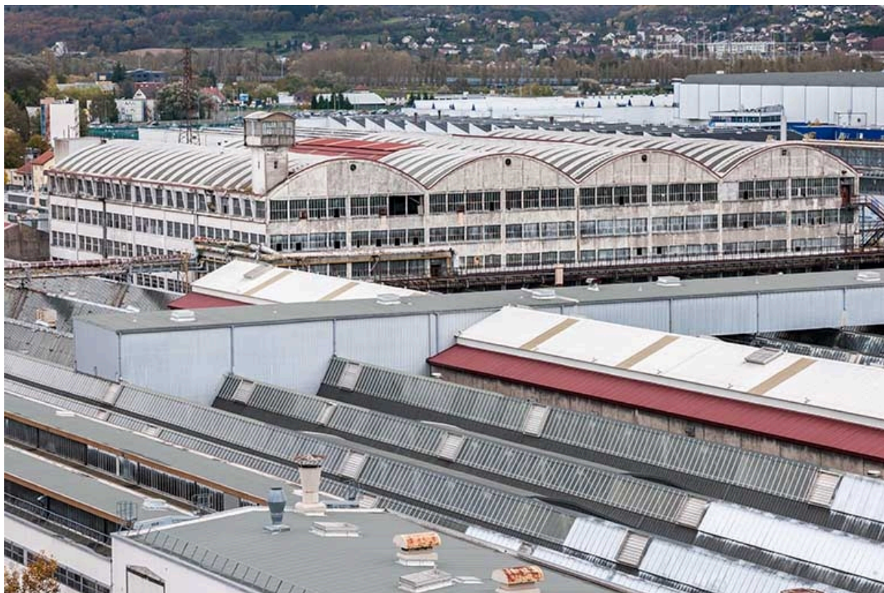
Automobile : usine Peugeot à Sochaux, vue de trois quarts de l'ancien entrepôt des véhicules (201).
